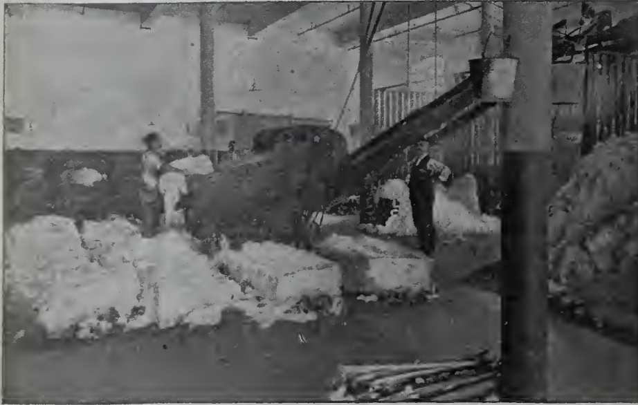
"Ouvreuse", machine qui ouvre et nettoie le coton brut.
